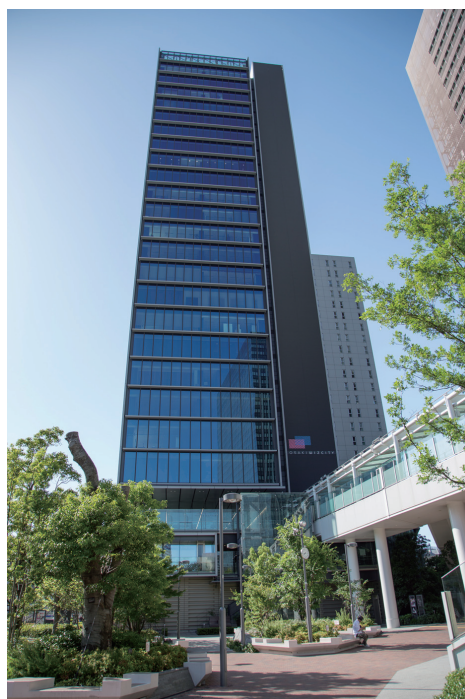
第一フロンティア生命 大崎本社
